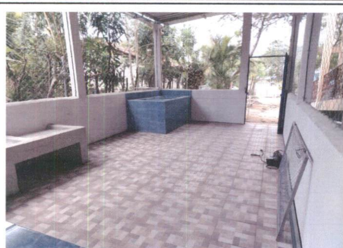
Foto 2: Mejoramiento de losa de piso e instalación de piso antideslizante en la cocina.
