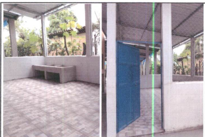
Foto 3: Polletón y puerta finalizada.
