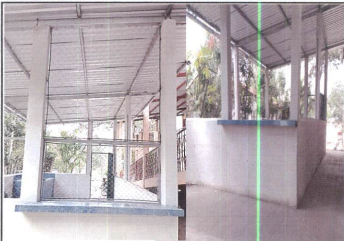
Foto1: En la estructura del pórtico de la cocina se dejó una ventanilla para recibir la alimentación escolar, así mismo se colocaron torta de cemento alrededor de la cocina.
